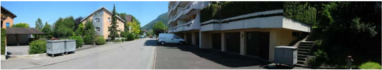
Abbildung 5: Terrassensiedlung an der verebneten Haldenstraße in Triesen (Photo: Catarina Proidl)
